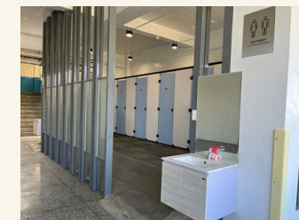
採光通風忠孝樓廁所
